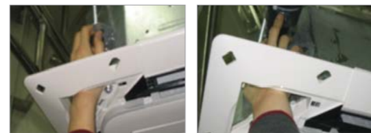
A függesztőszerelvény beállítása A cseppvíz szivárgásának ellenőrzése
